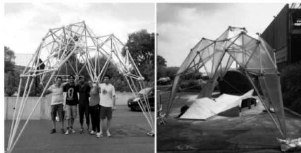
1-расм. Фрактал асосидаги панжара қобиғининг тузилиши (а) панелсиз ва (б) қоплама панеллари билан.
